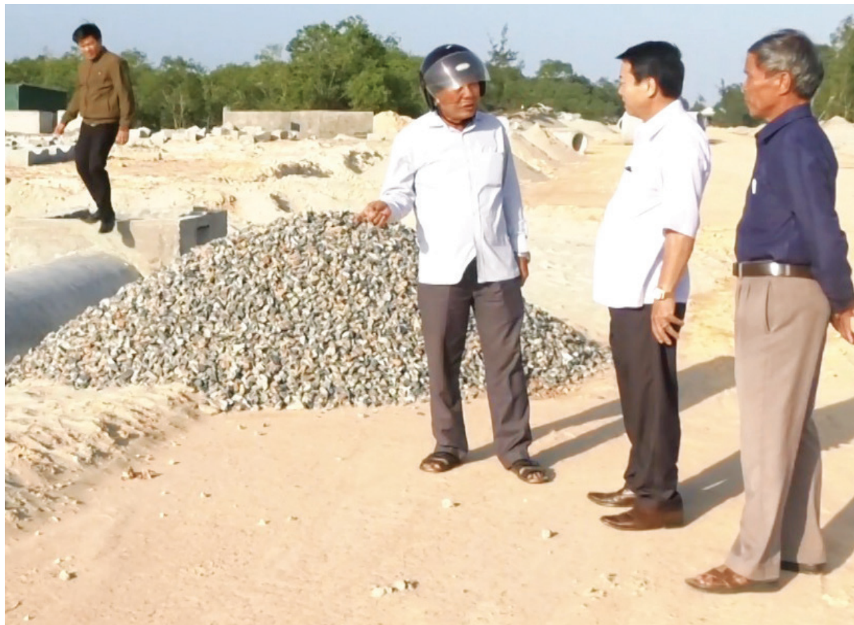
Tổ giám sát cộng đồng tại xã An Hải, huyện Hải Lăng tham gia giám sát dự án xây dựng tại địa phương. Ảnh: HY
