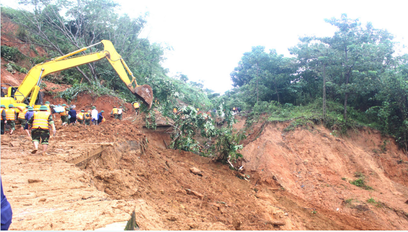
Mặt trận các cấp cùng chính quyền, lực lượng vũ trang, người dân tham gia khắc phục thiệt hại do mưa lũ, sạt lở đất tại huyện Hương Hoá. Ảnh NP
