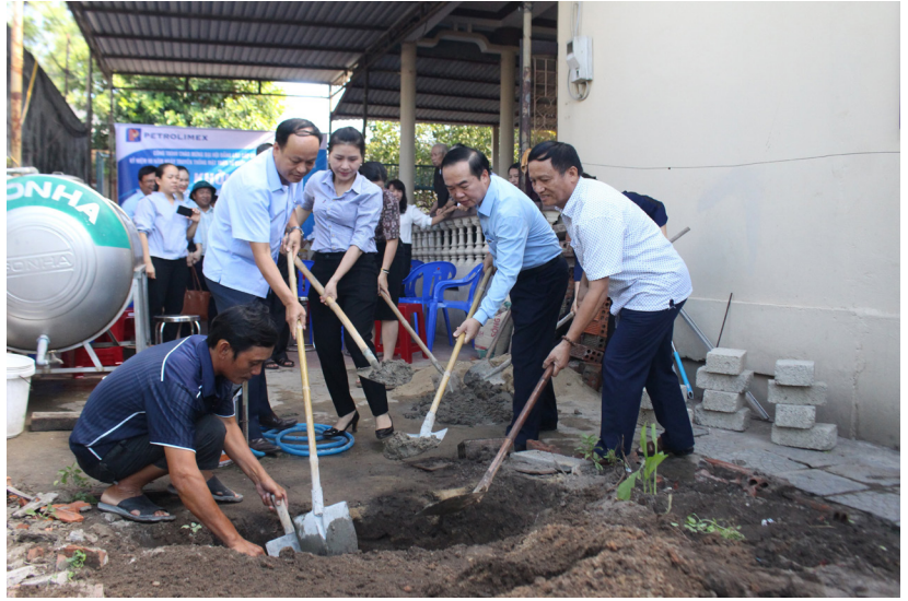
Lễ Khởi công xây dựng nhà Đại đoàn kết cho gia đình bà Lê Thị Hiền, Khu phố 6, Phường 3, thành phố Đông Hà. Ảnh: NP
