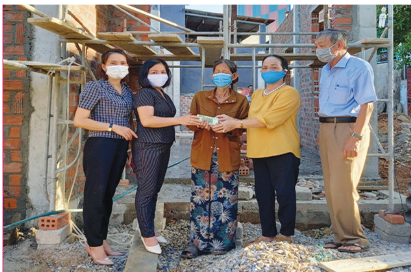
Ủy ban MTTQ Việt Nam phường và Ban Công tác Mặt trận khu phố trao tiền hỗ trợ xây dựng nhà đại đoàn kết cho hộ ông Phan Văn Long hộ nghèo Khu phố 9, Phường 5
