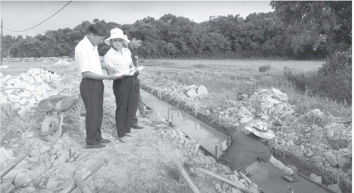
Ban GSĐTCCĐ xã Vĩnh Long, huyện Vĩnh Linh đang thực hiện giám sát công trình mương thủy lợi đang xây dựng trên địa bàn xã. Ảnh PN
