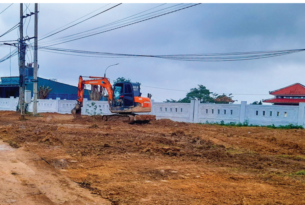
Dự án san nền mặt bằng Khu tái định cư Tân Trúc, xã Cam Hiếu được Ban GSDTCCĐ giám sát, đảm bảo chất lượng, tiến độ thi công
